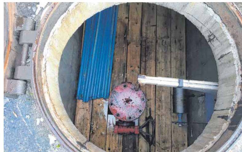
Vom Holzpodest aus können die blauen Stahlrohre in die Tiefe gelassen werden.
