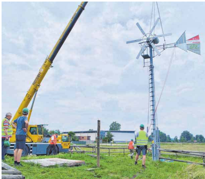
Mithilfe der Firma Reisch wird das Windrad des Schülerforschungszentrums Bad Saulgau auf der Kälberweide aufgestellt.
